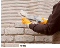
ADIM 2 Osalıklı dış cephe uygulamasında tuğlaların arkasına da Stonerap yapıştırma harcı sürün.
