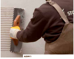
ADIM 1 Tuğla kaplamaya uygun yüzeye sürülen Stonerap yapıştırma harcıncı harçla mabla ile yayın.
