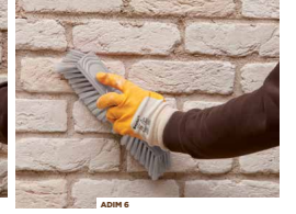
ADIM 6 Temiz ve yumuşak bir fırça ile yüzeyi temizlemiş ve derz tam olarak kurumuş dış cephe uygulamalarına su itici uygulayın.
