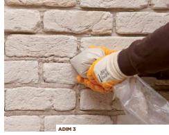
ADIM 3 Derz boşluğu kullanılarak renkli Stonerap derz harcı ile tuğla aralarını doldurun.
